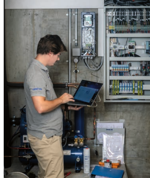
▲ Le projeteur frigoriste contrôle les paramètres du programme qui pilote le système de refroidissement.
